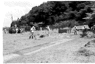
除草作業状況
